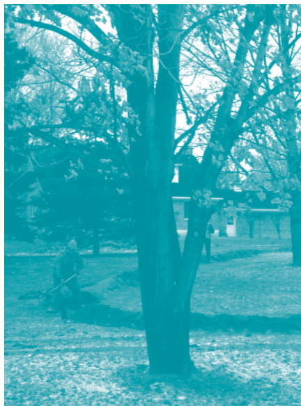
Installation d'une boucle souterraine pour une maison existante.
